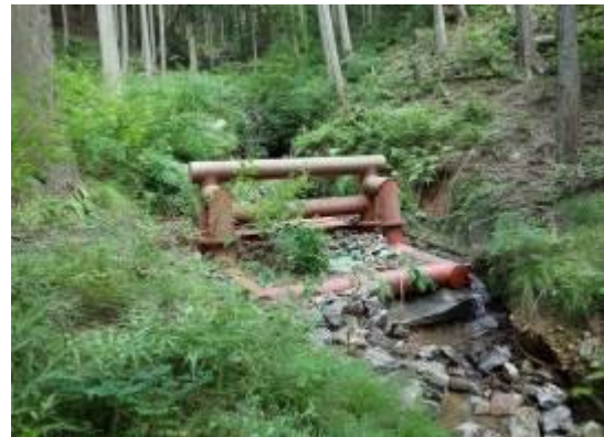
緊急防災林整備 (簡易流木止め工)
