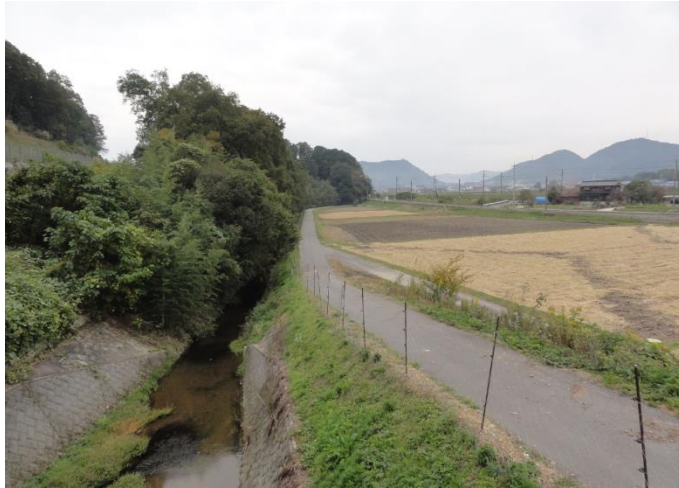
福地川堤防の嵩上げ
