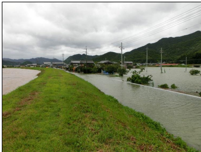
平成25年台風第18号の浸水状況
