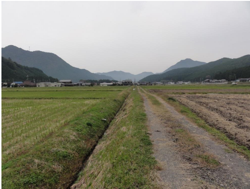
水田貯留及び水路の改修
