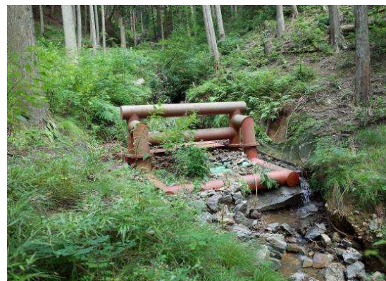
緊急防災林整備 (簡易流木止め工)
