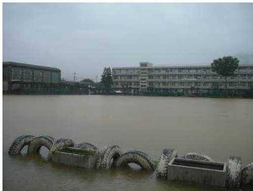
校庭貯留（左写真：西脇中学校校庭貯留（平成 26 年 8 月）右写真：高砂市立阿弥陀小学校）
