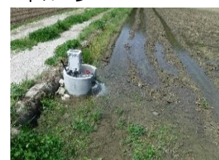
用水路を管路化し遠隔操作型自動給水栓を設置（丹波市）
