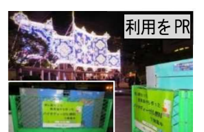
利用をPR ルミナリエでは東遊園地でB5軽油を発電用燃料として使用
