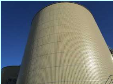
メタン発酵槽
