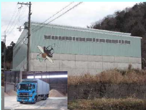
オガ粉保管施設
