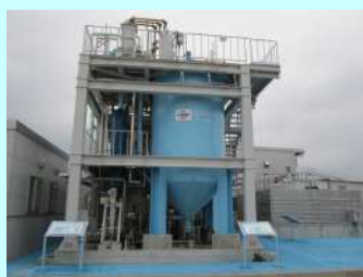
リン回収施設
