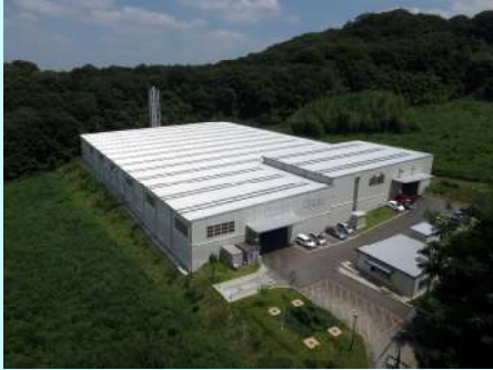
三木堆肥化センター(全景)
