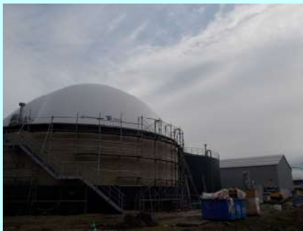
バイオガス発酵槽等の設備（工事中）
