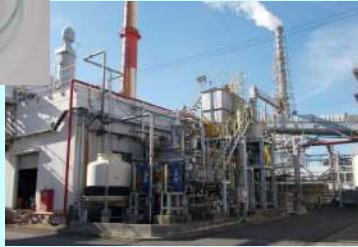
汚泥乾燥燃料と汚泥乾燥施設
