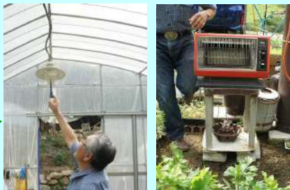
バイオガス利用設備のガス灯やストーブ
