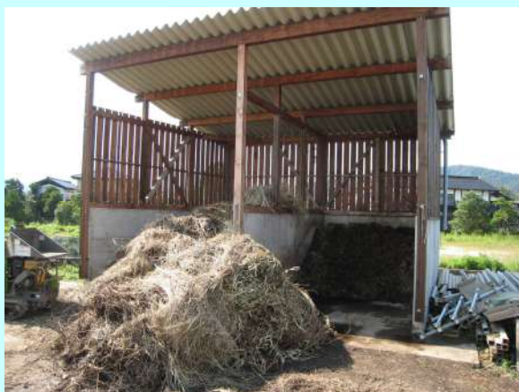
発酵保管施設
