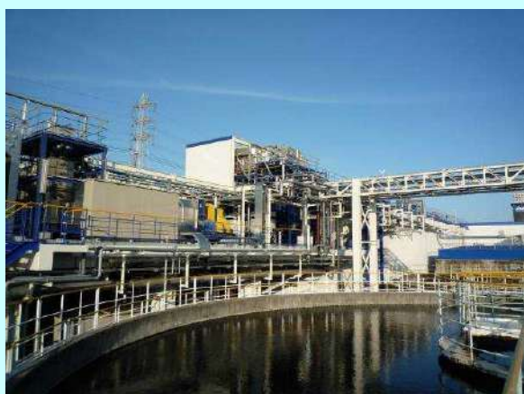
メタン発酵施設
