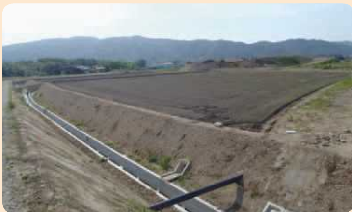
田面より1m程度低い位置に排水路を設置
