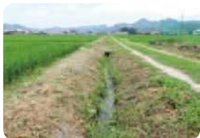
用排水兼用の土水路
