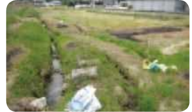
漏水が多く、用排兼用の水路
