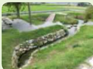
環境水路や水辺公園の整備
