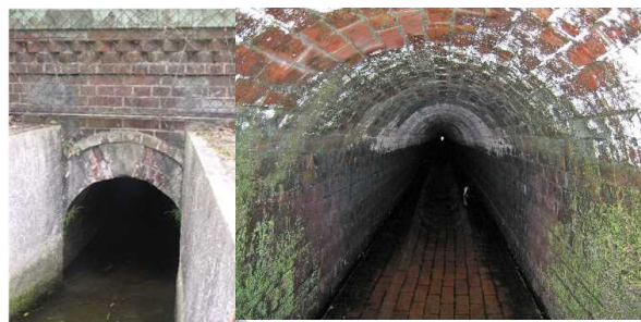
現在も利用される煉瓦造りの水路トンネル
