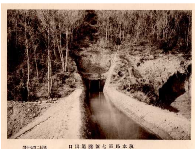
山を貫く水路トンネル（建設当時）
