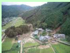
豪雨により崩壊した斜面
