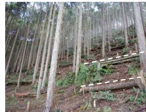
（伐採木を利用した土留工）
