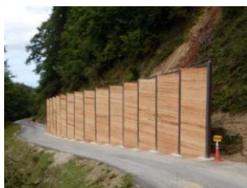
県産木材を使用した 仮設防護柵（香美町）
