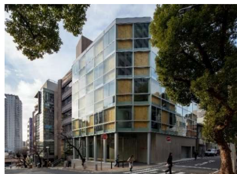
兵庫県林業会館（神戸市）
