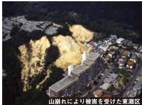
住居のすぐ側まで土砂が押し寄せる
