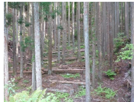
土留工施工直後
