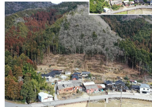
整備直後の状況
