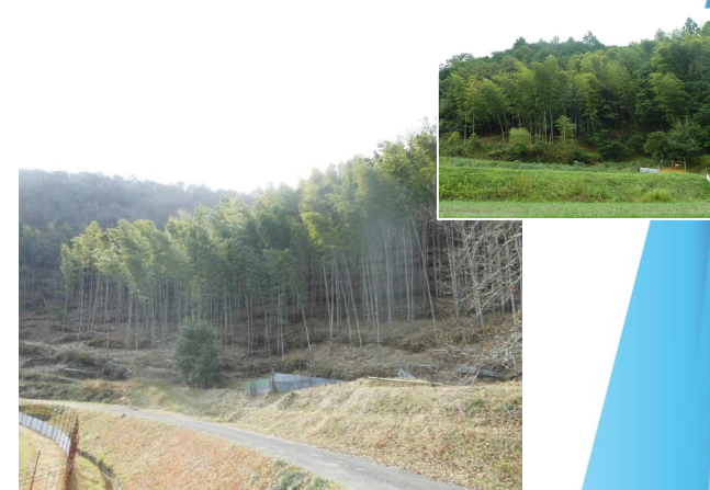
整備直後の状況
