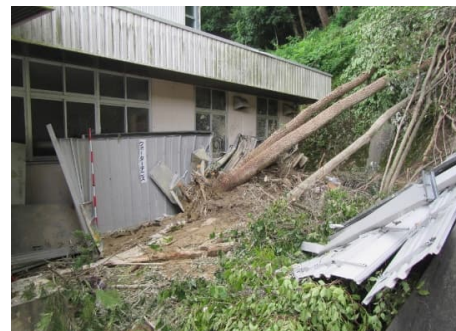
豪雨により小学校の体育館が被災
