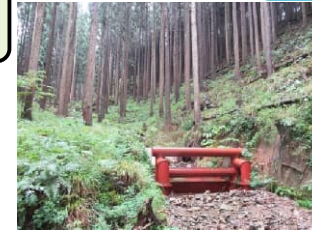
緊急防災林整備（斜面对策）
