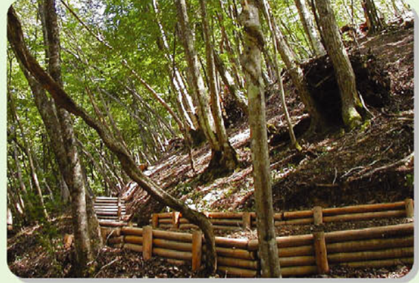
▲ 柵工（表土の流出を留める簡易な防災施設）
