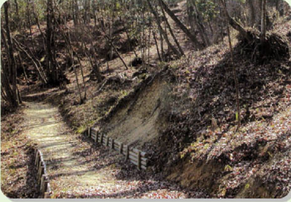
▲ 巡視にも活用する管理歩道
