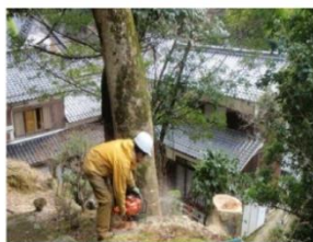
人家裏山の危険木伐採
