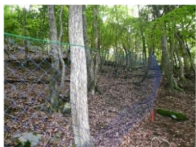
植生保護柵の設置
