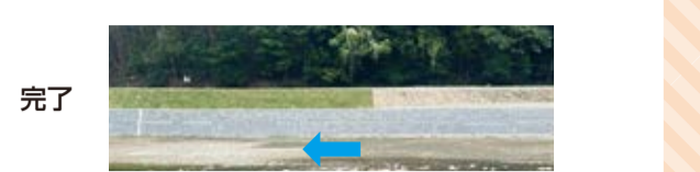
護岸整備工事(令和7年度完了)
