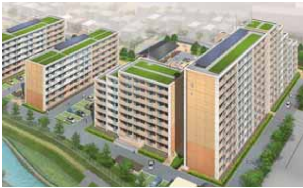
県営住宅の整備：建替事業
