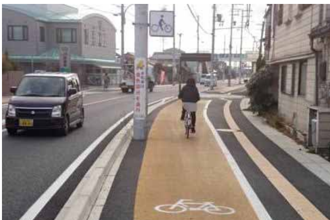
歩行者・自転車の安全対策の推進：歩道上のカラー舗装
