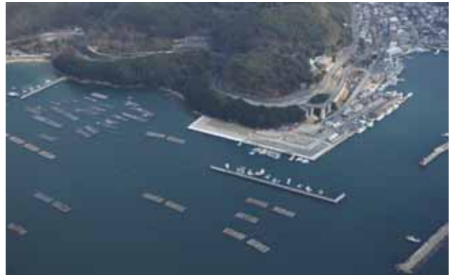
水産業基盤の整備：漁港整備(漁船係留施設など)
