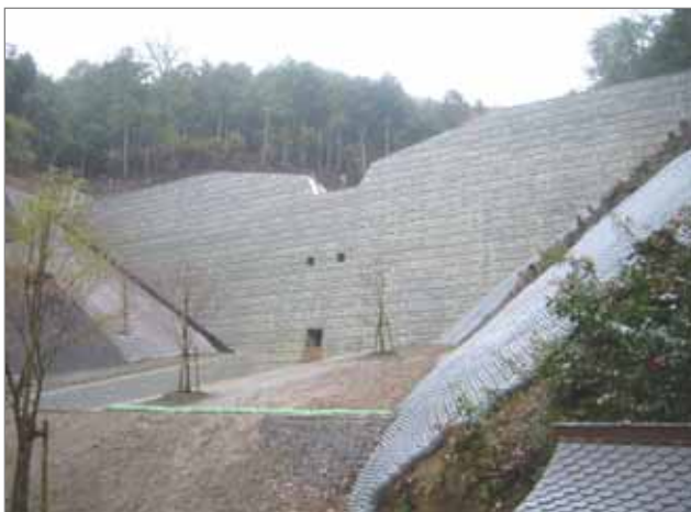
土砂災害対策の推進：砂防えん堤の整備
