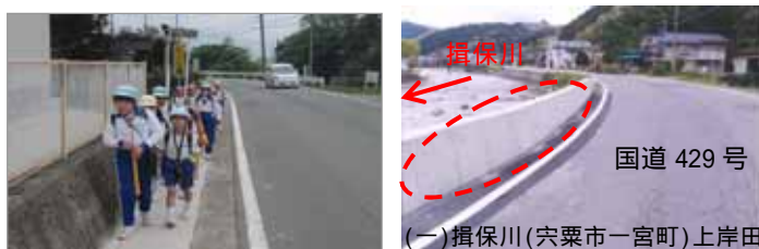
歩行者対策：側溝蓋掛け 局所的な越水対策：既設護岸の嵩上げ
