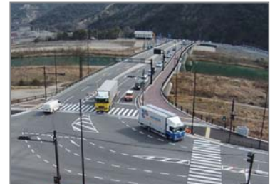
国道 250号 坂越道路 (赤穂市)
