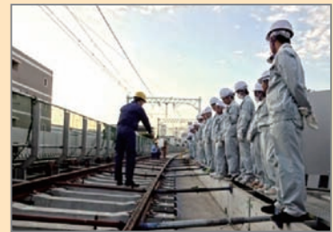
建設業魅力アップ現場研修会 県内土木系の高校生を対象とした現場研修会 (阪神電鉄連続立体交差事業(鳴尾駅付近))
