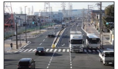
道路の拡幅 都市計画道路 尼崎宝塚線 武庫川交差点 (尼崎市)
