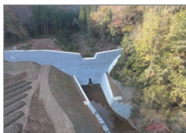
白谷川砂防えん堤(新温泉町)
