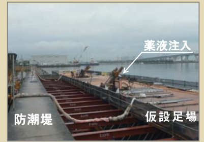
沈下対策の施工状況 [薬液注入により防潮堤直下の地盤を改良]
