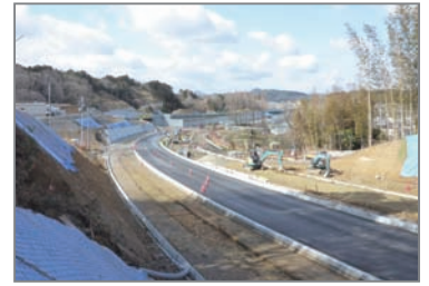
県道 川西インター線 (川西市)
