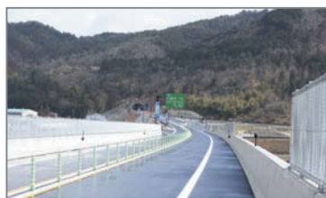
北近畿豊岡自動車道 八鹿日高道路(養父市) (H29.3.25開通)
