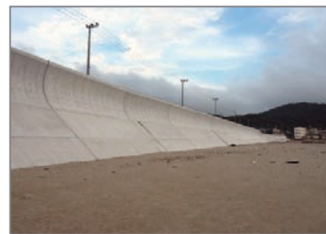
防潮堤 阿万港（南あわじ市）
