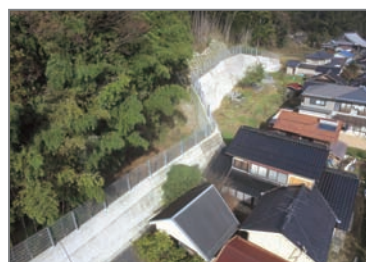
安賀地区 急傾斜地対策(宍粟市)
