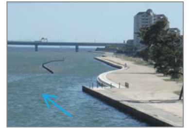
武庫川下流部築堤区間の河道拡幅(施工中)(西宮市)
