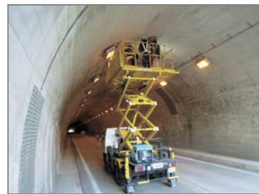
トンネル点検 県道 若桜湯村温泉線 湯村トンネル(新温泉町)
