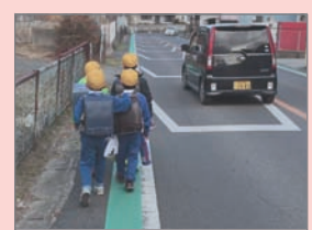
路肩のカラー舗装（グリーン） 県道 広田洲本線 (洲本市)
