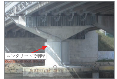
橋脚耐震補強 県道 東播磨港線 播磨大橋 (播磨町)
