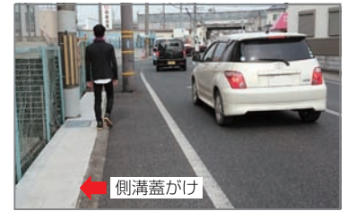
側溝蓋がけ 県道 野谷平岡線(加古川市)
