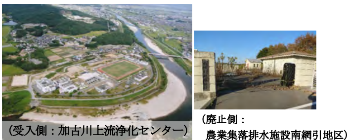
下水処理施設の広域化・共同化
