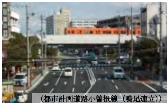
駅周辺のまちづくりのため連続立体交差事業
