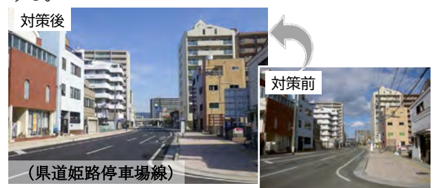
防災機能の強化等を目的とした無電柱化
