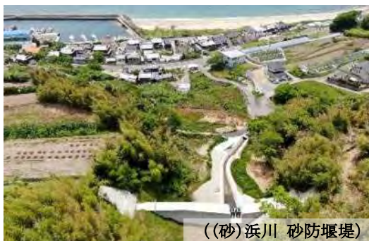
土砂災害から人家等を守る砂防堰堤整備
