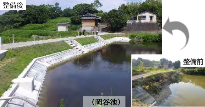
決壊リスクに備えるため池改修
