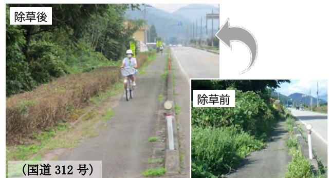
日常の維持管理(道路除草)
