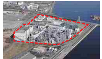
兵庫東流域下水汚泥広域処理場 (尼崎市)
