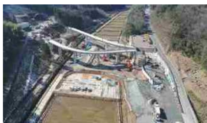
北近畿豊岡自動車道 日高豊岡南道路（仮称）豊岡南IC付近（豊岡市）
