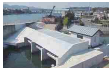
陀仏川樋門【洲本市】
