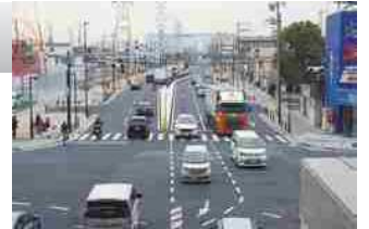
道路の拡幅 武庫川交差点 (尼崎市)
