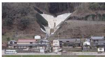
桐谷川砂防堰堤（佐用町）
