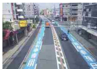
自転車レーン 県道 姥ヶ茶屋伊丹線(伊丹市)
