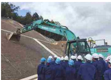
県内土木系の 高校生を対象 とした現場見学会 (県立豊岡総合高校)
