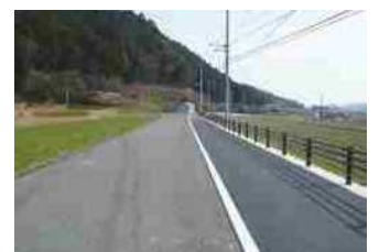
路肩拡幅 県道 大和北条停車場線(加西市)
