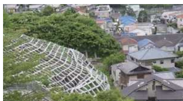
鈴蘭台西町地区急傾斜地対策（神戸市）
