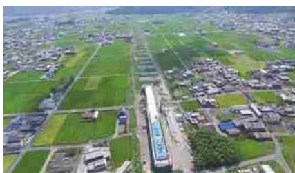
国道175号西脇北バイパス（西脇市）
