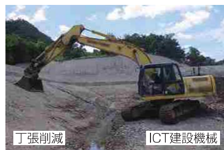
ICT建設機械 による法面整形 施工状況
