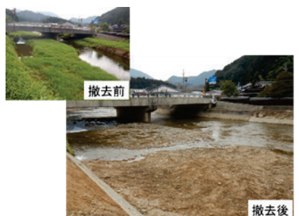
与布土川 堆積土砂撤去 (朝来市)
