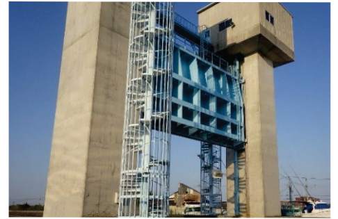
ゲート扉体再塗装 天川防潮水門（高砂市）
