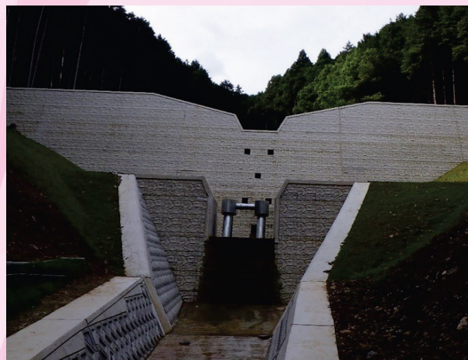
奥塩久谷川 砂防堰堤（丹波市）
