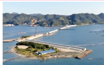
福良港 湾口防波堤(南あわじ市)
