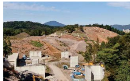
北近畿豊岡自動車道 豊岡道路 (仮称)豊岡IC付近(豊岡市)
