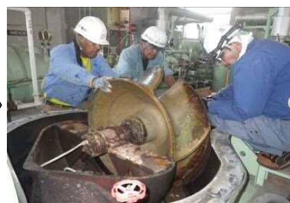
対策工事の実施
