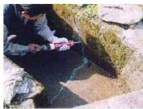
水路のひび割れ補修
