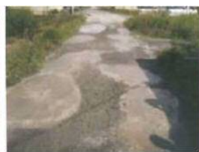
農道の窪みの補修
