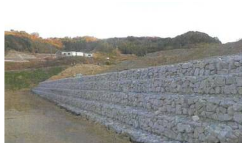
対策工事(かご工) 大坪地区
