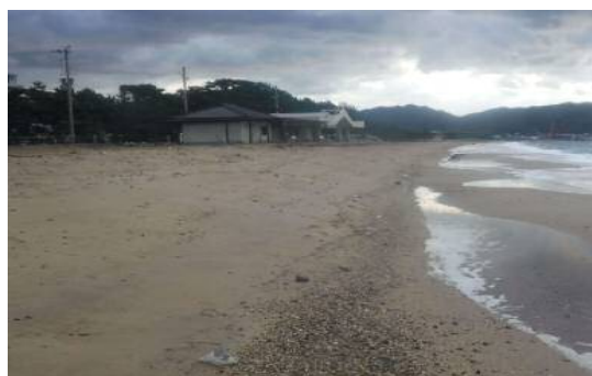
応急工事実施後の古津路海岸 (R4. 12)
