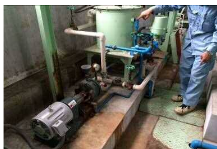
施設の機能診断実施
