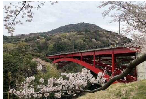
鮎屋夢大橋（ひょうごの橋・トンネル 150 選）
