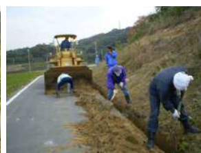
水路の泥上げ
