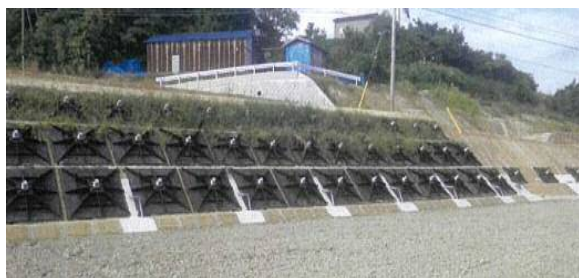
対策工事(アンカー工) 生田大坪地区
