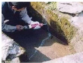
水路のひび割れ補修
