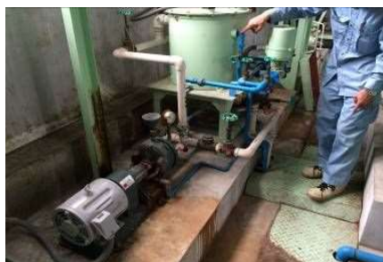
施設の機能診断実施
