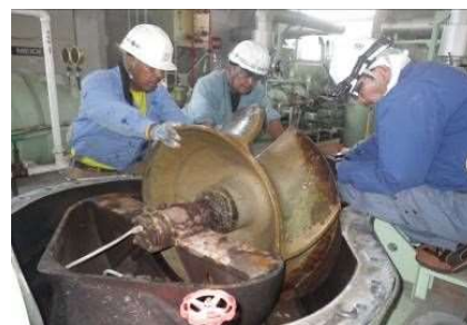
対策工事の実施
