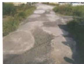
農道の窪みの補修
