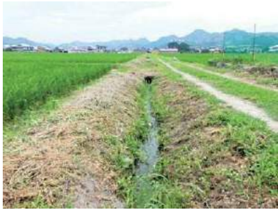
用排水兼用の土水路
