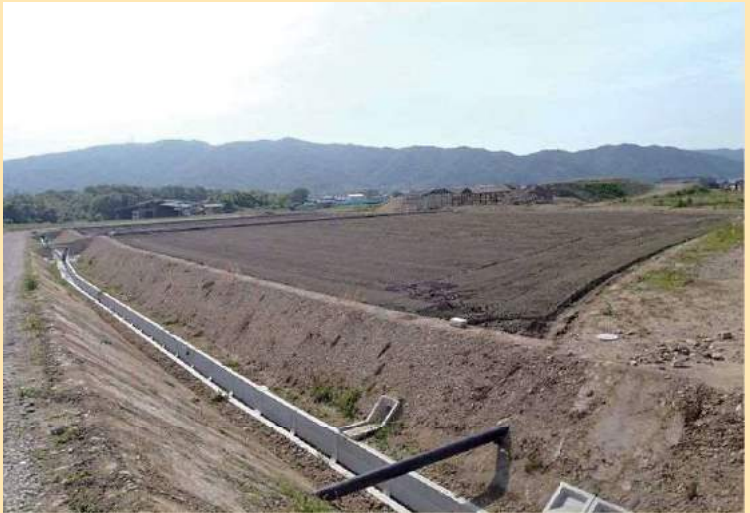
田面より1 m程度低い位置に排水路を設置
