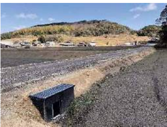
写真：排水路敷がパイプライン化された農道
