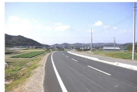
南淡工区供用区間
