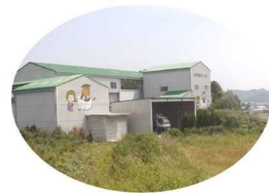
地力回復センター（南あわじ市）
