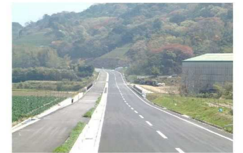
緑工区供用区間
