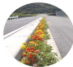
植樹帯の植栽状況
