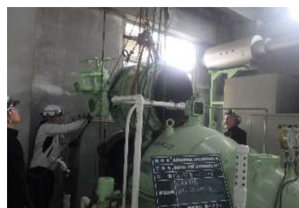
対策工事の実施
