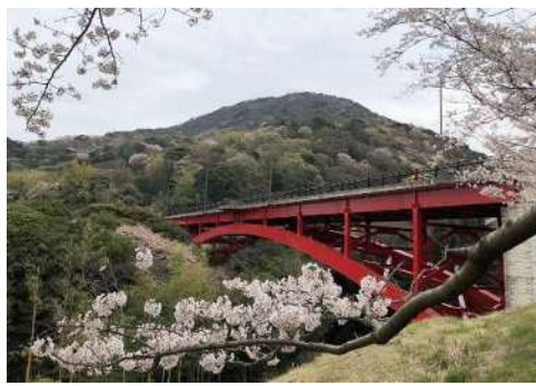
鮎屋夢大橋(ひょうごの橋・トンネル 150 選)
