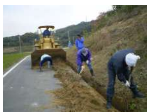
水路の泥上げ
