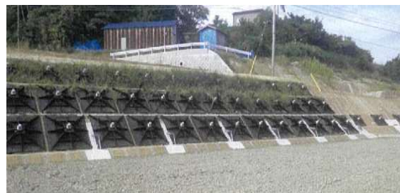
対策工事(アンカー工) 生田大坪地区
