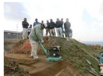
ため池堤体の補修指導
