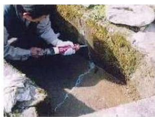
水路のひび割れ補修
