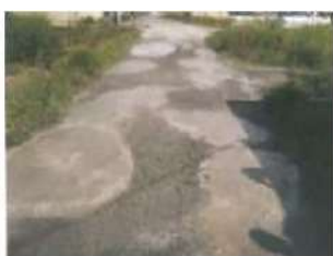
農道の窪みの補修
