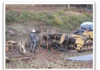
水抜きボーリング工
