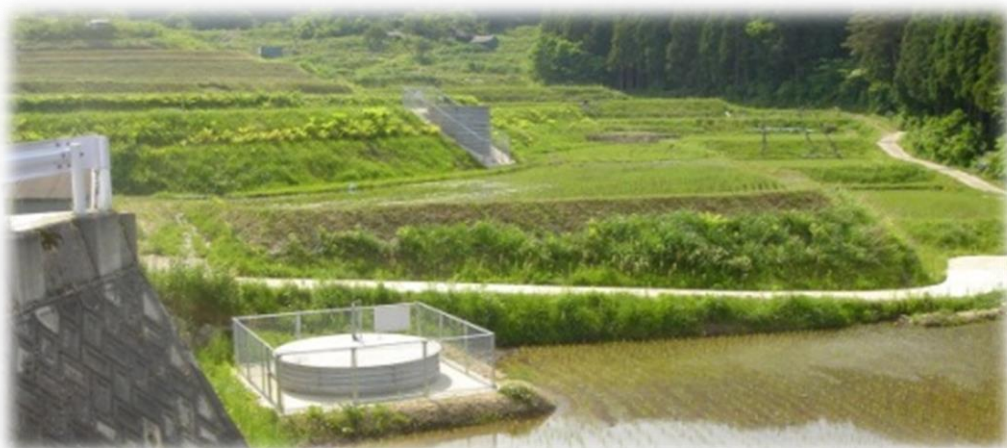
対策工事により農地を保全 口大谷地区（香美町）
