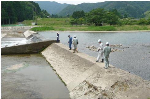
点検を行い、危険な状態と なっていないか確認します。
