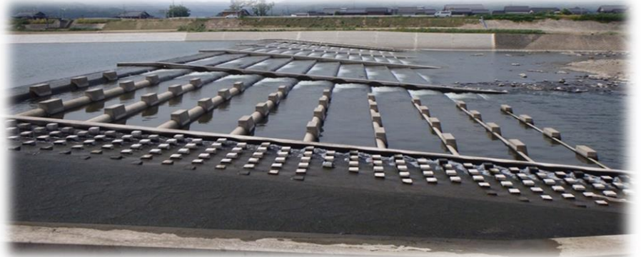
全国的にも珍しい 全面魚道タイプの 井堰に改修しました。
