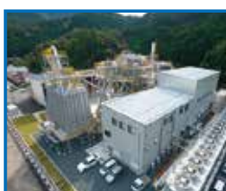
木質バイオマス発電所 (朝来市)
