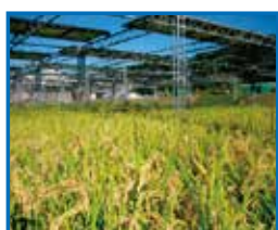
ソーラーシェアリング [営農型太陽光発電](宝塚市)
