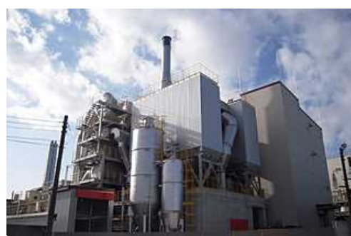
焼却施設外観
