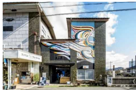
外観（鉄骨造部分）
