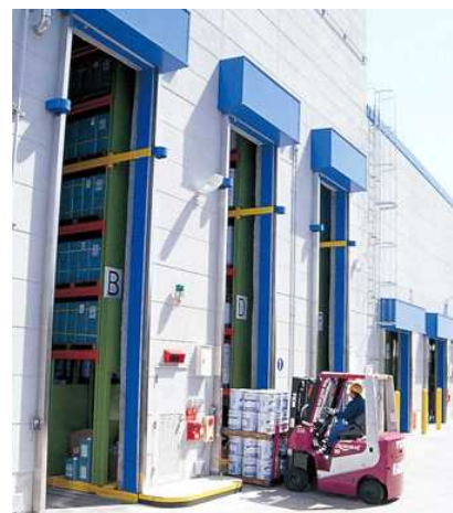
危険品倉庫(中島営業所)
