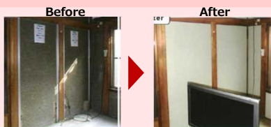
床と天井に壊さず工事を実施
