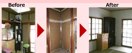
土壁に壊さず工事を実施
