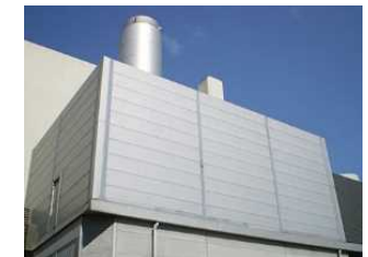
神戸ポートピアホテルの発電施設
