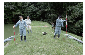
ため池保全サポートセンターによる 巡回点検(三田市)
