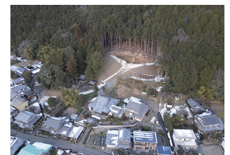
人家等保全対策を目的とした 治山ダム(丹波市)
