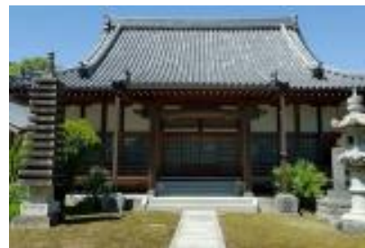
施工例① 加古川市の浄土宗の寺院 安楽寺本堂
