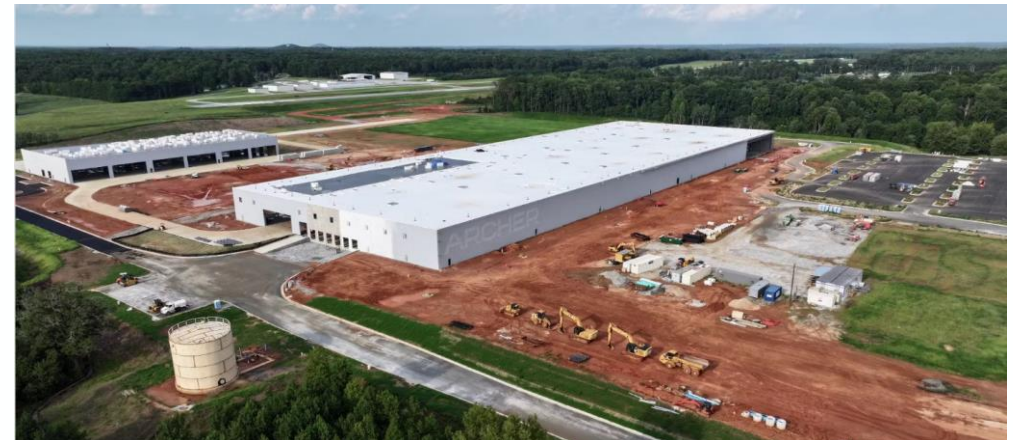
ジョージア州コビントン製造工場 (建設中)
