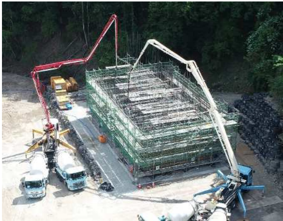
(参考) 工事の様子(令和 8 年 5 月撮影)
