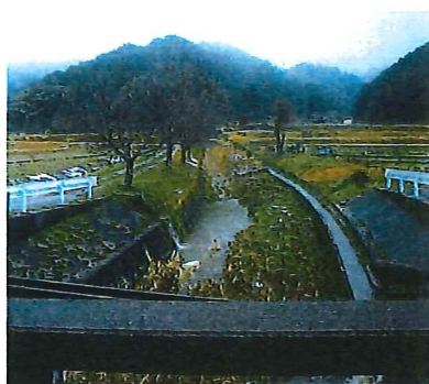
堆積土砂撤去前（日高町）
