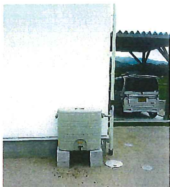
家庭用雨水貯留タンク設置
