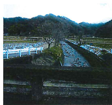
堆積土砂撤去後（日高町）
