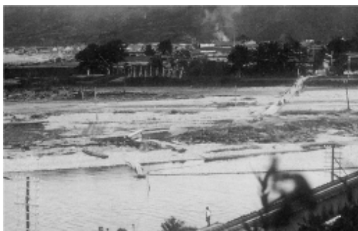
香住町（当時）の矢田橋付近の状況
