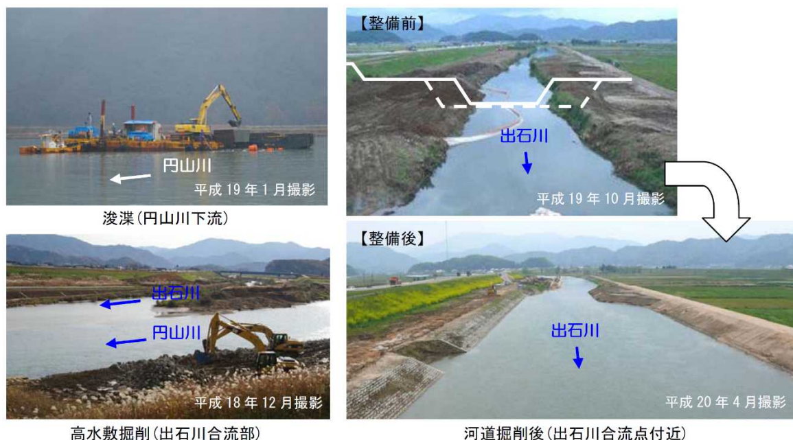
図 1.3.1 激特事業による河道掘削の状況
