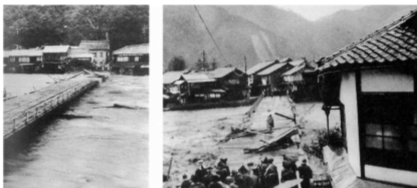
八鹿町（当時）の円山川の屋岡大橋で 欄干に乗り上げた流木（左）と流木をさばく様子（右）
