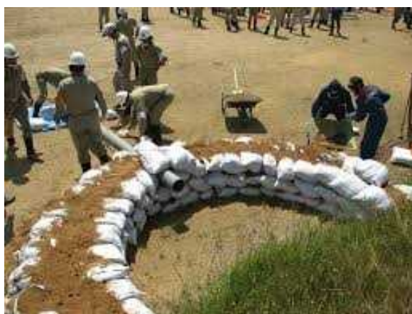
図 6.4.3 六方河川防災ステーションで行われた水防演習（月の輪工法）
