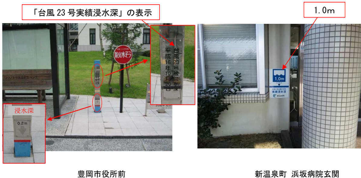
図 6.1.4 実績浸水深表示板の事例（自治体）
