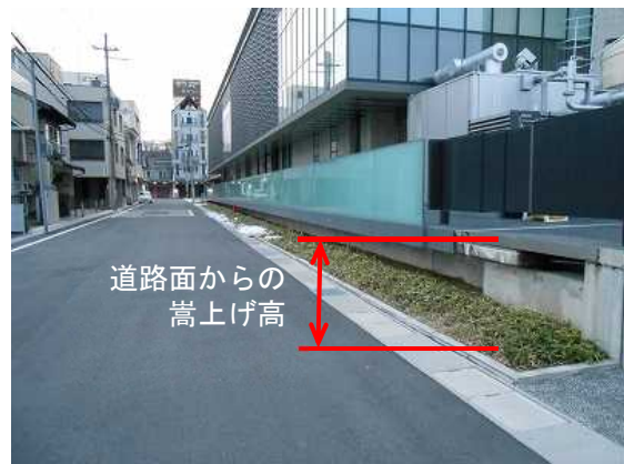
図 6.6.2 豊岡市役所の耐水化事例
