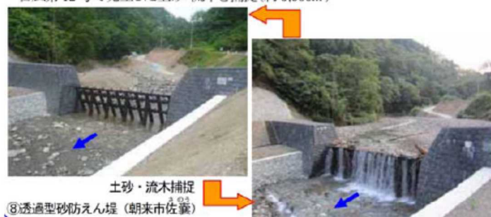
朝来市の神子畑川における砂防堰堤による土砂の捕捉状況（2011（平成 23）年台風 12 号）
