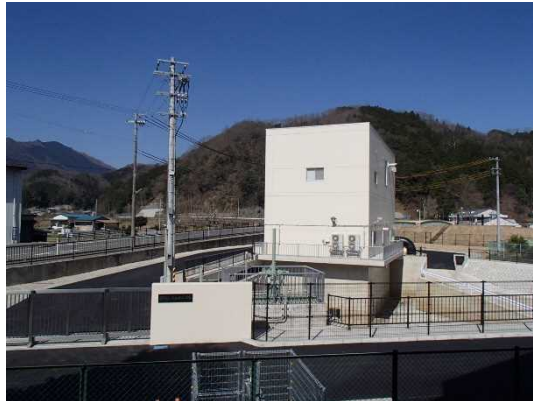
立ノ原ポンプ場
