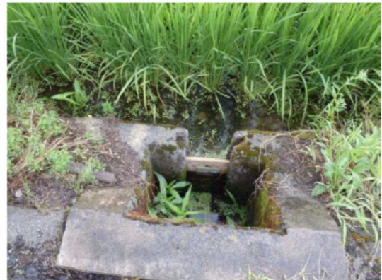
せき板の設置状況
