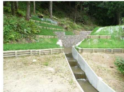
豊岡市出石町奥山 里山防災林の整備（床固工）
