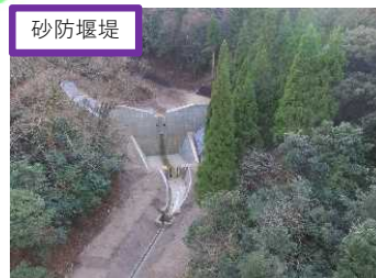
赤崎川砂防堰堤（新温泉町）
