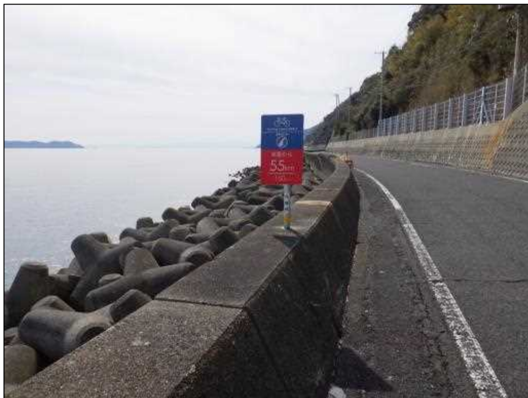
設置状況 [アワイチ]
