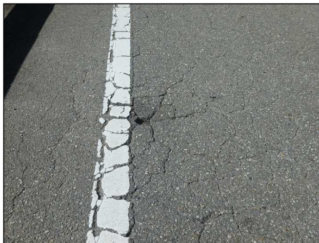
舗装のひび割れ
