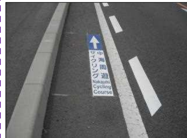
路面表示タイプの設置事例 [鳥取県]
