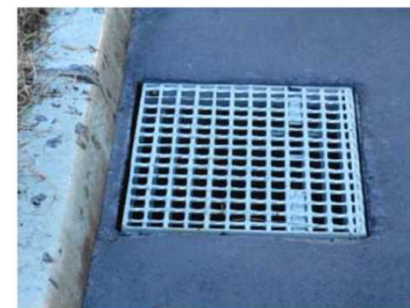
グレーチング蓋の格子の形状を工夫した事例
