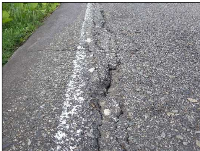
舗装のひび割れ
