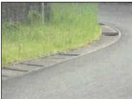
側溝の蓋掛け
