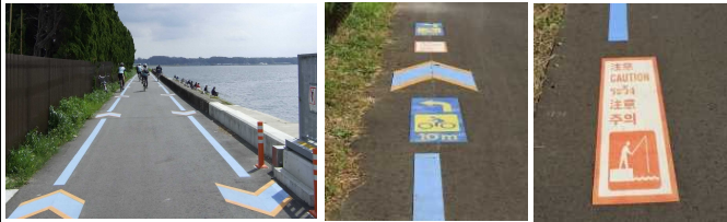
(路面表示施工例)
