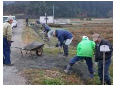
工事の直営施工
