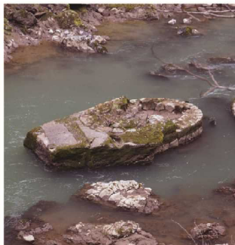
昔の第一篠山川橋りょうの土台の名残
