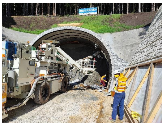
トンネル掘削状況
