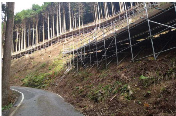
工事現場の状況
