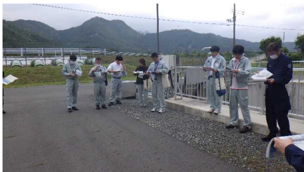
丹波市公共下水道東部雨水ポンプ場
